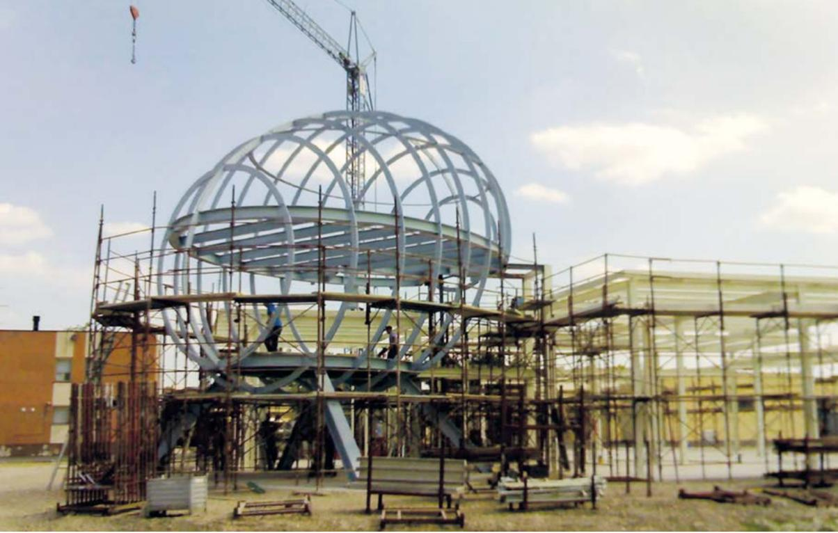
↑↓ Vedute del telaio della struttura in costruzione.
