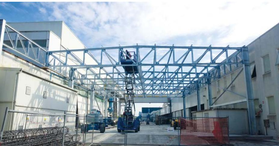
↑ Dettagli della copertura in costruzione dello stabilimento della Cooperativa Ceramica d'Imola.
