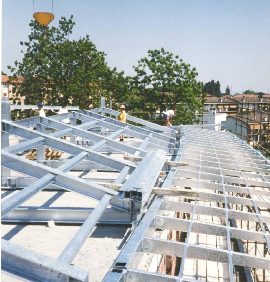
↑ La struttura in acciaio del coperto.
