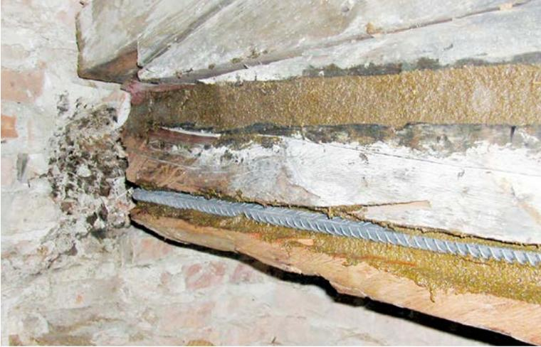
← Consolidamento dell'appoggio della vecchia catena con barra di acciaio e resine.
