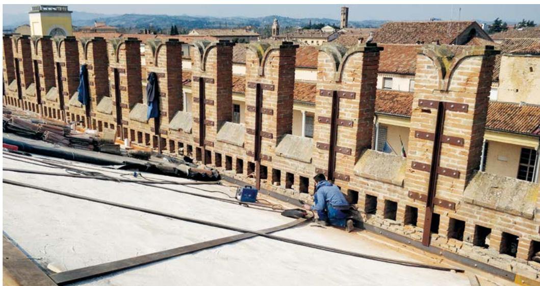
→ Ha completato l'intervento l'inserimento di diaconi artificiali lungo tutta la superficie delle pareti, in modo da rendere i paramenti interno ed esterno uniti tra loro, e infine la messa in sicurezza contro il ribaltamento dei merletti in muratura, i quali sono stati solidarizzati al cordolo in ferro del coperto attraverso degli elementi metallici verticali nascosti nel retro.
