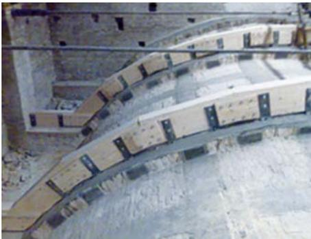
←↘ Applicazione di contro-archi in legno lamellare "cuciti" con la volta muraria sottostante tramite fasciature in fibra di carbonio.
