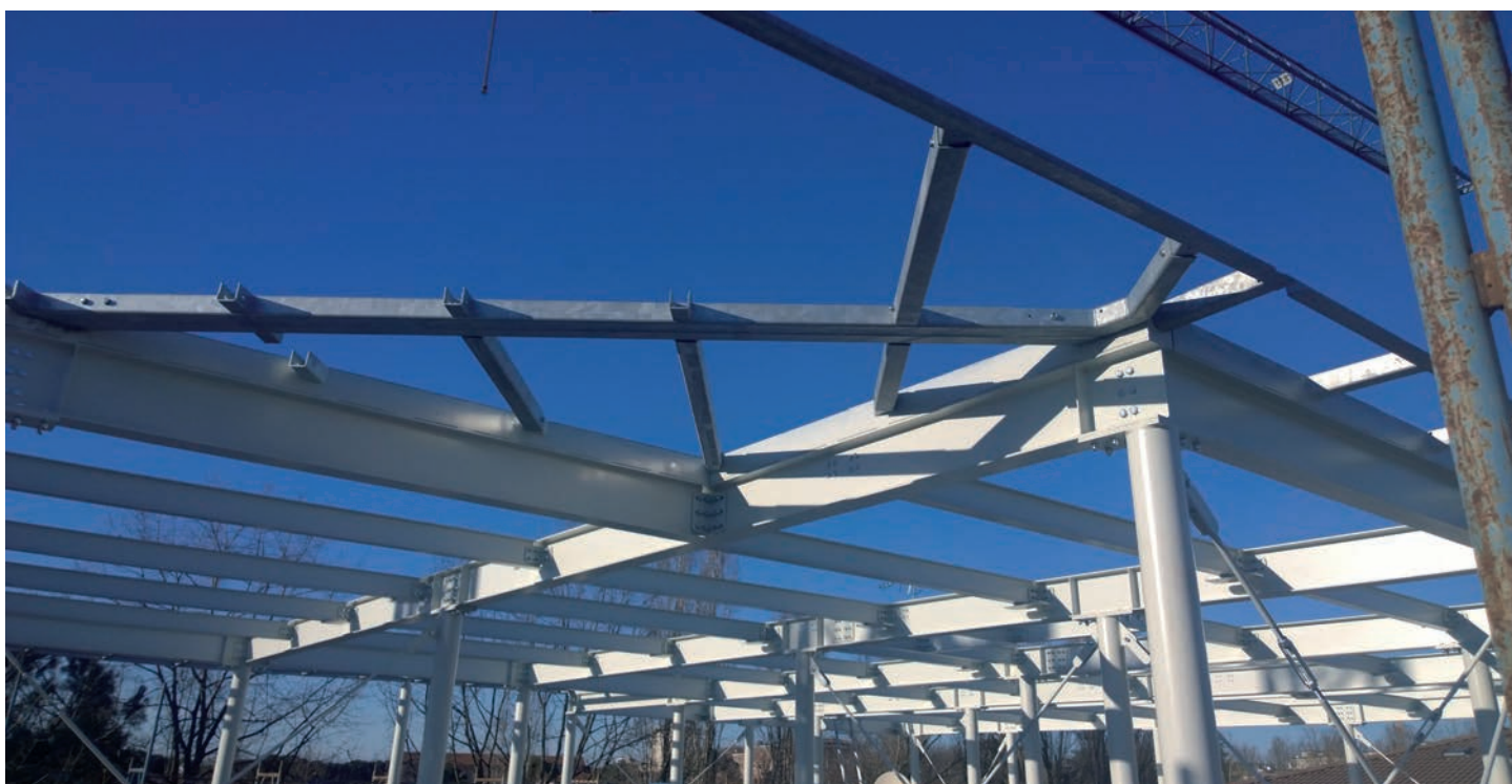
La struttura metallica della sopraelevazione: fasi di montaggio in cantiere.
