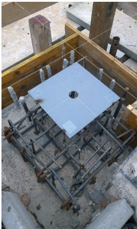
Armatura di base dell'isolatore con contropiastra di fissaggio.
