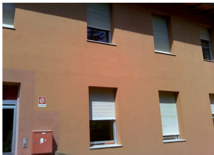
Figura 2. Rilievo con camera termografica dell'edificio.
