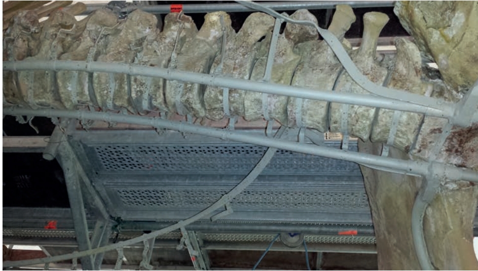
Figura 2. Particolare del telaio portante delle ossa del mammut in ferro.
