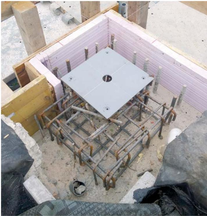
Fig. 15 - Armatura di base dell'isolatore con contropiastra di fissaggio
