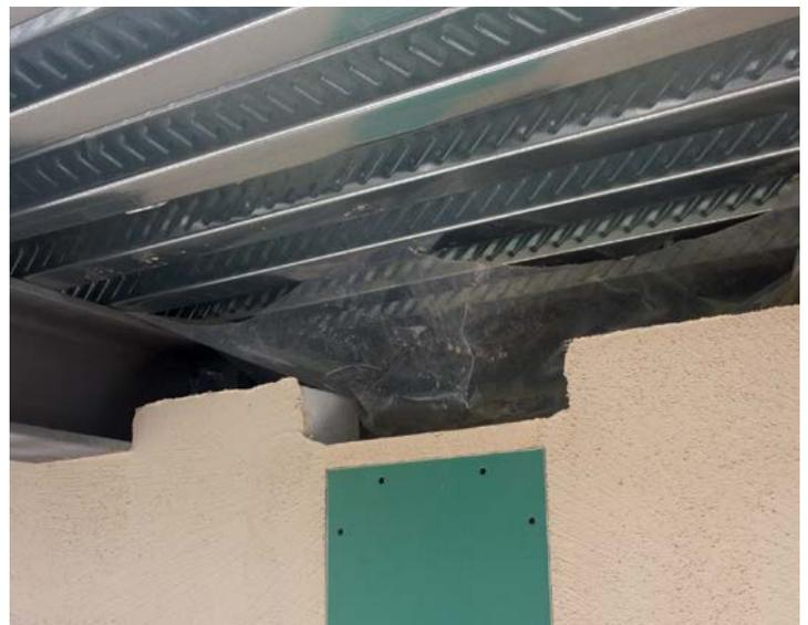
Fig. 21 - Particolare cassetto esterno in cartongesso per l'ispezione degli iso
