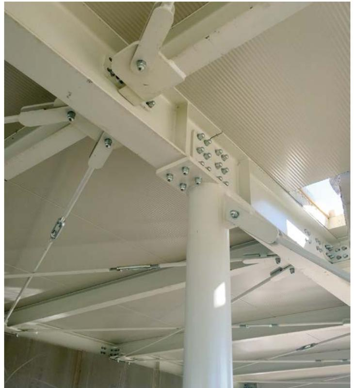
Fig. 20 - Particolare nodi metallici interni
