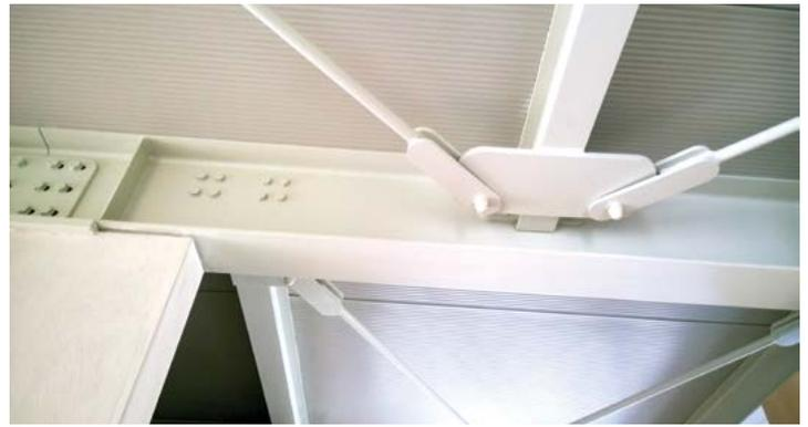
Fig. 19 - Particolare nodo metallico interno tra trave e controvento
