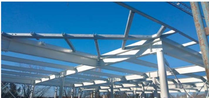
Fig. 17 - Montaggio della struttura metallica di sopraelevazione
