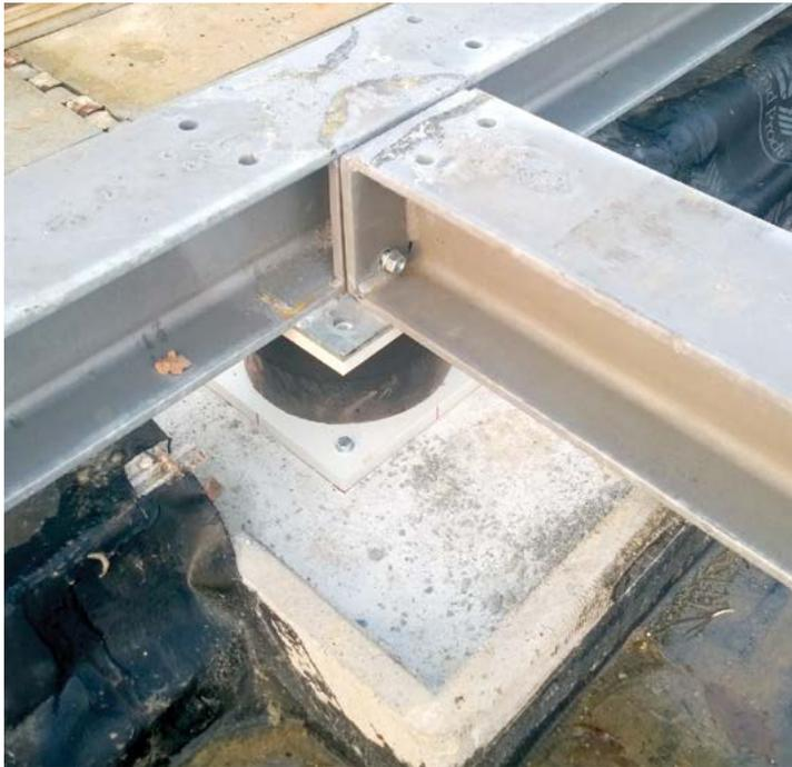
Fig. 16 - Particolare dell'impalcato metallico posato sull'isolatore sismico
